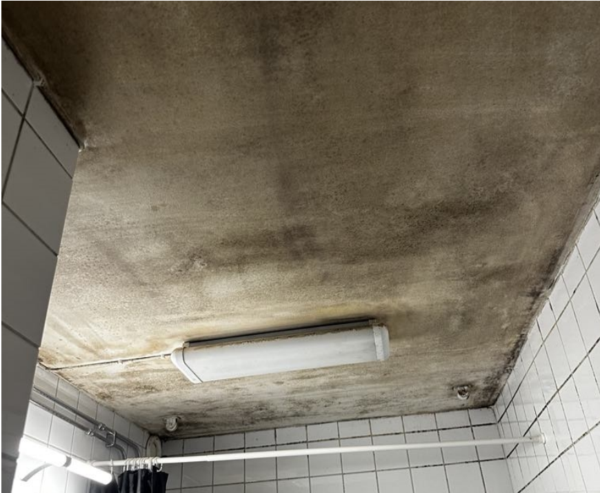
Bild 5, missfärgningar på ett badrumstak. Förelagt om vidare utredning.
