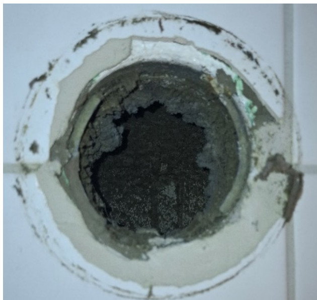
Bild 2, igensmutsad frånluftskanal.
