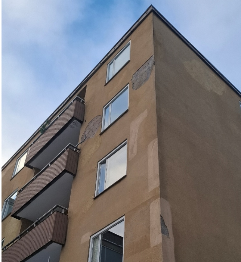
Bild 4, skadad putsad fasad.
