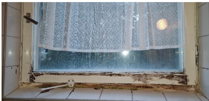
Bild 3, fukt- och mikrobiell påväxt på fönsterkarm i badrum.
