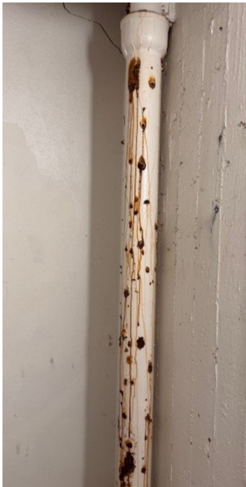
Bild 1, avloppsstam på källarplan med genomgående korrosion.
